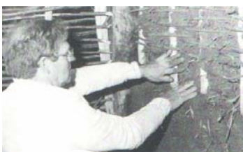
Auftragen der ersten Lehmschicht
