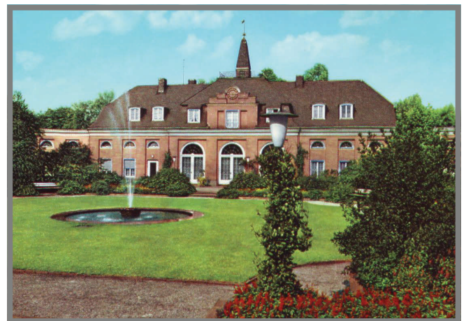
Schloss Oberhausen nach der Restauration 1960
