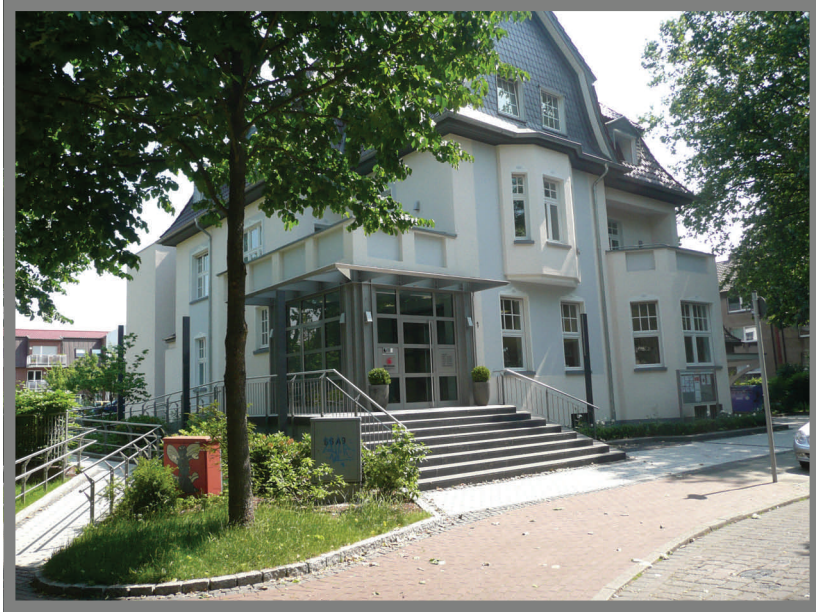
Heute nach Umbau durch die Gemeinnützige Wohnungsbaugesellschaft Sterkrade
